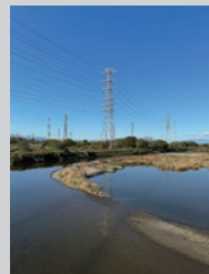
【COVER PHOTO】 北関東の送電線のある風景
