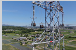
【COVER PHOTO】 工事が進む新加古川線改良工事、架線工事の様子
