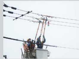
【COVER PHOTO】 関西電力送配電線の配電作業の状況
